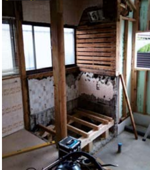
■Before 解体して洗濯機置き場へ
