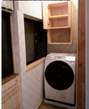
■After 洗濯機置き場
