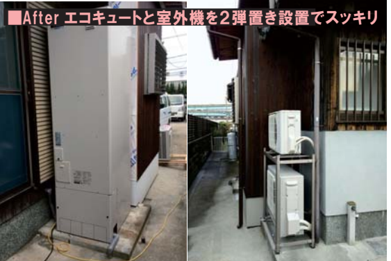
■After エコキュートと室外機を2弾置き設置でスッキリ
